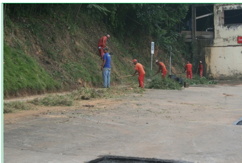
Figura 3.14 – Limpeza / Capina executada manualmente por empregados.
